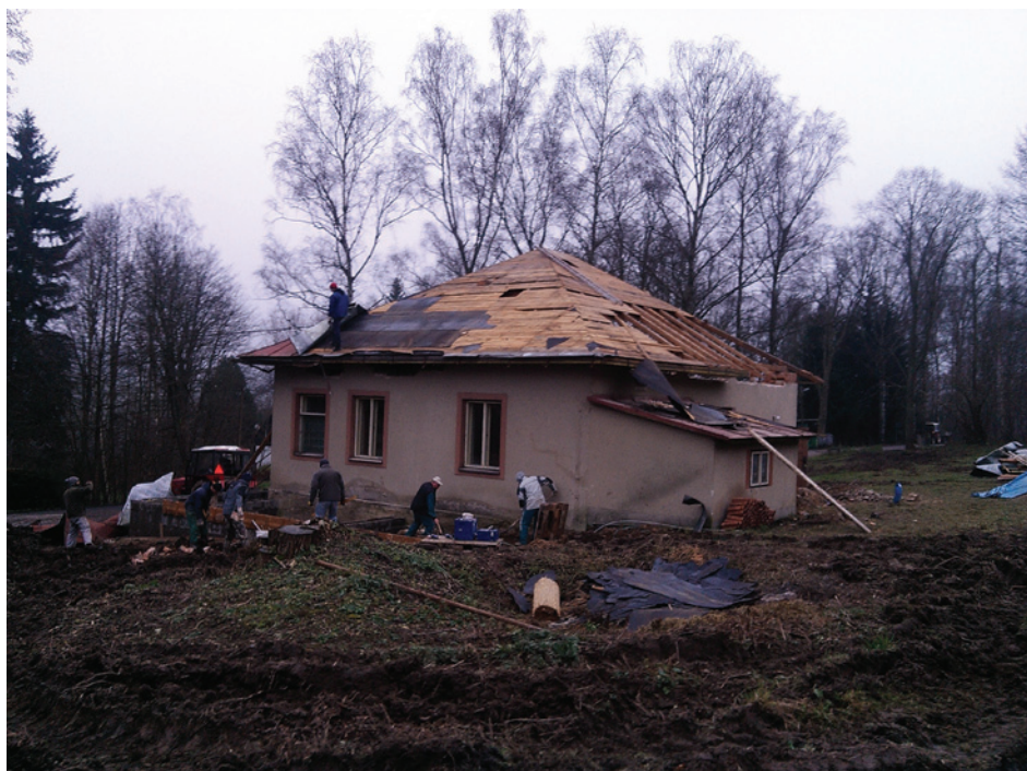
Dům České Milovy 31 před rekonstrukcí
