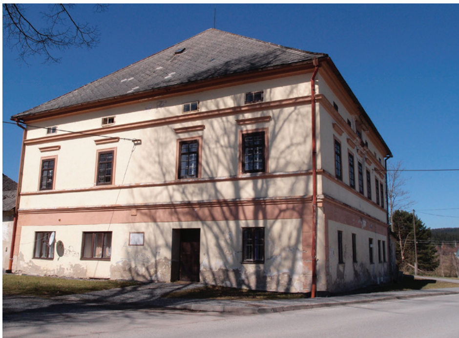
Dům Moravské Křižánky 45 před rekonstrukcí
