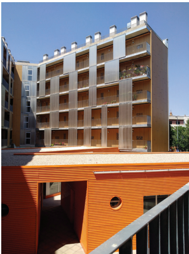
Nový bytový dům organizace AVRA v Seville
