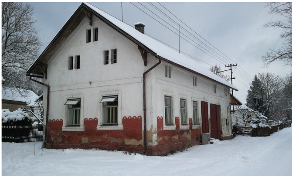
Dům Moravské Křižánky 96 před rekonstrukcí
